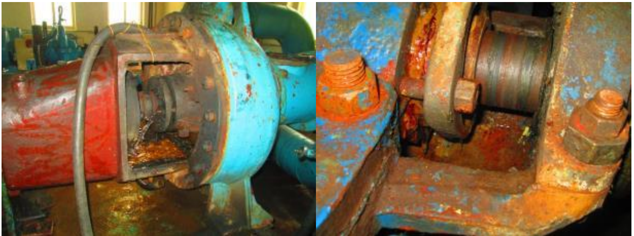
Рисунок 35 – Визуальное обследование станции II подъёма ОСВ (здание 3)
