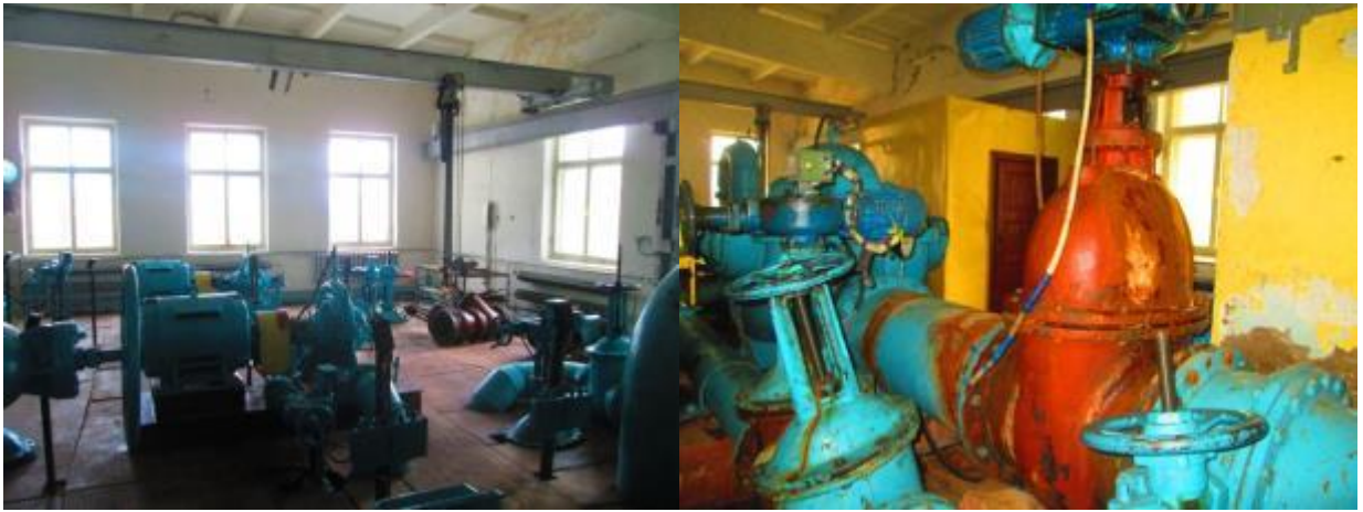
Рисунок 34 – Визуальное обследование станции II подъёма ОСВ (здание 3)
