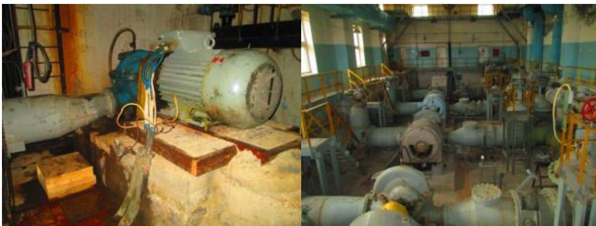
Рисунок 33 – Визуальное обследование насосной станции I подъёма и II подъёма ОСВ (здание 1 и здание 23)
