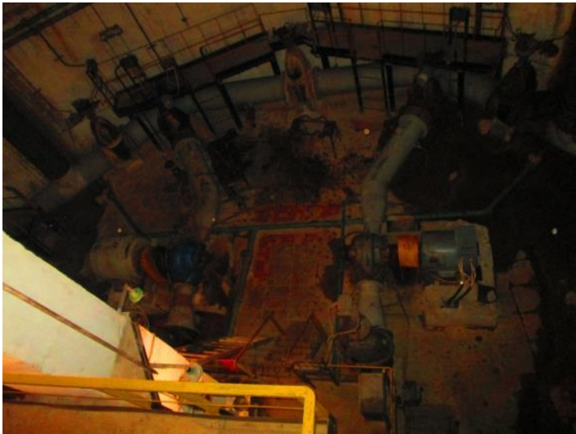
Рисунок 32 – Визуальное обследование насосной станции I подъёма ОСВ (здание 1)
